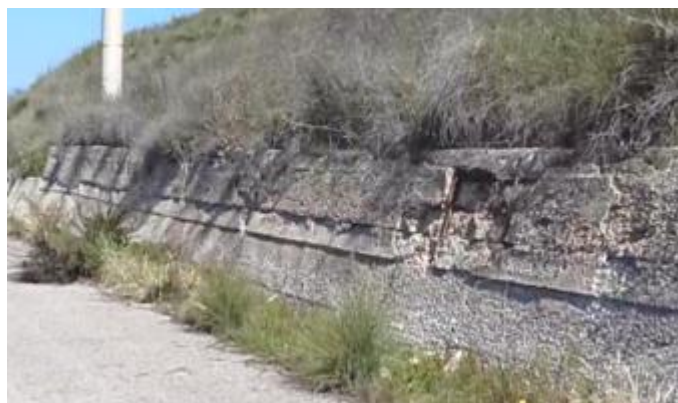
Figura 4-7: Muro di sostegno fortemente ammalorato intorno a tra pk 760,0
