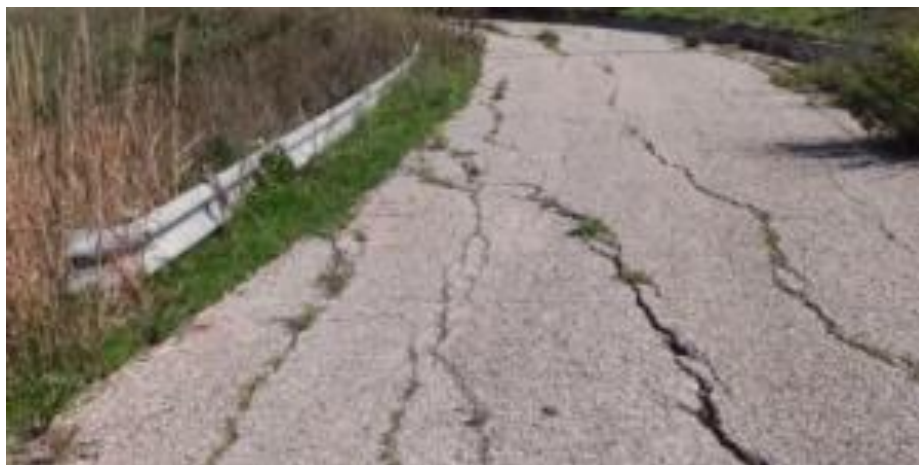
Figura 4-1: Dissesti tra pk 280,0 e pk 410,0 causati da deformazioni lente
