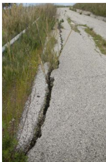
Figura 4-1: Dissesti tra pk 280,0 e pk 410,0 causati da deformazioni lente
