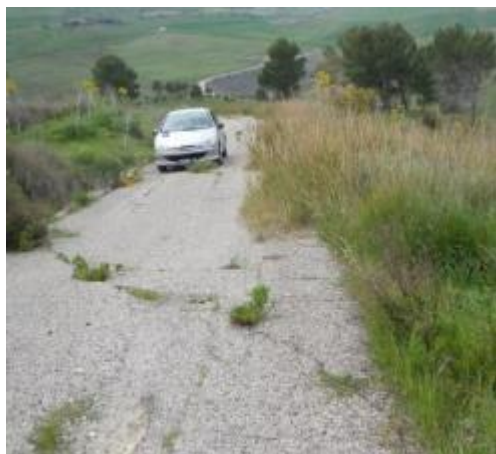
Figura 4-2: Dissesti tra pk 410,0 e pk 560,0 causati da deformazioni lente
