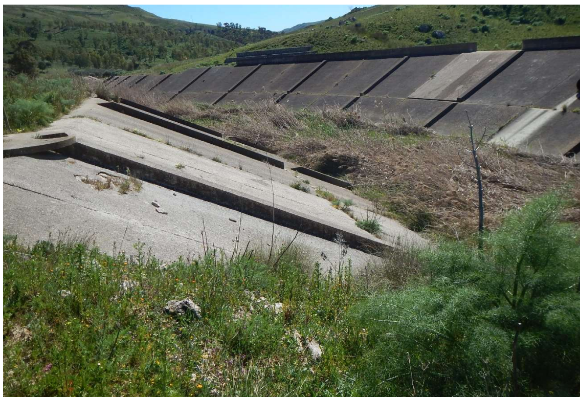
Figura 3.3: Canale di restituzione in alveo
