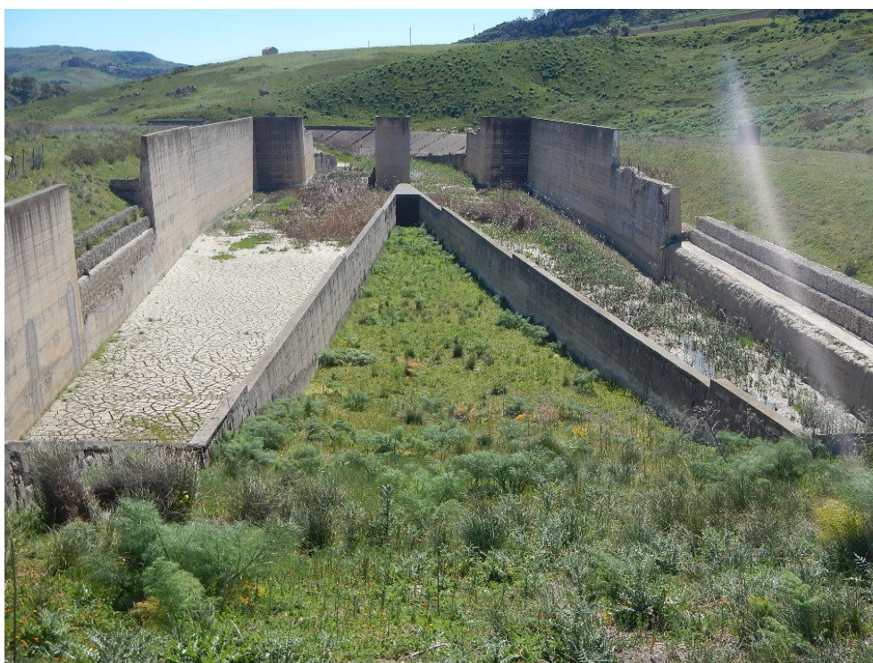
Figura 5.3: Vasca di dissipazione – Porzioni di muro crollate
