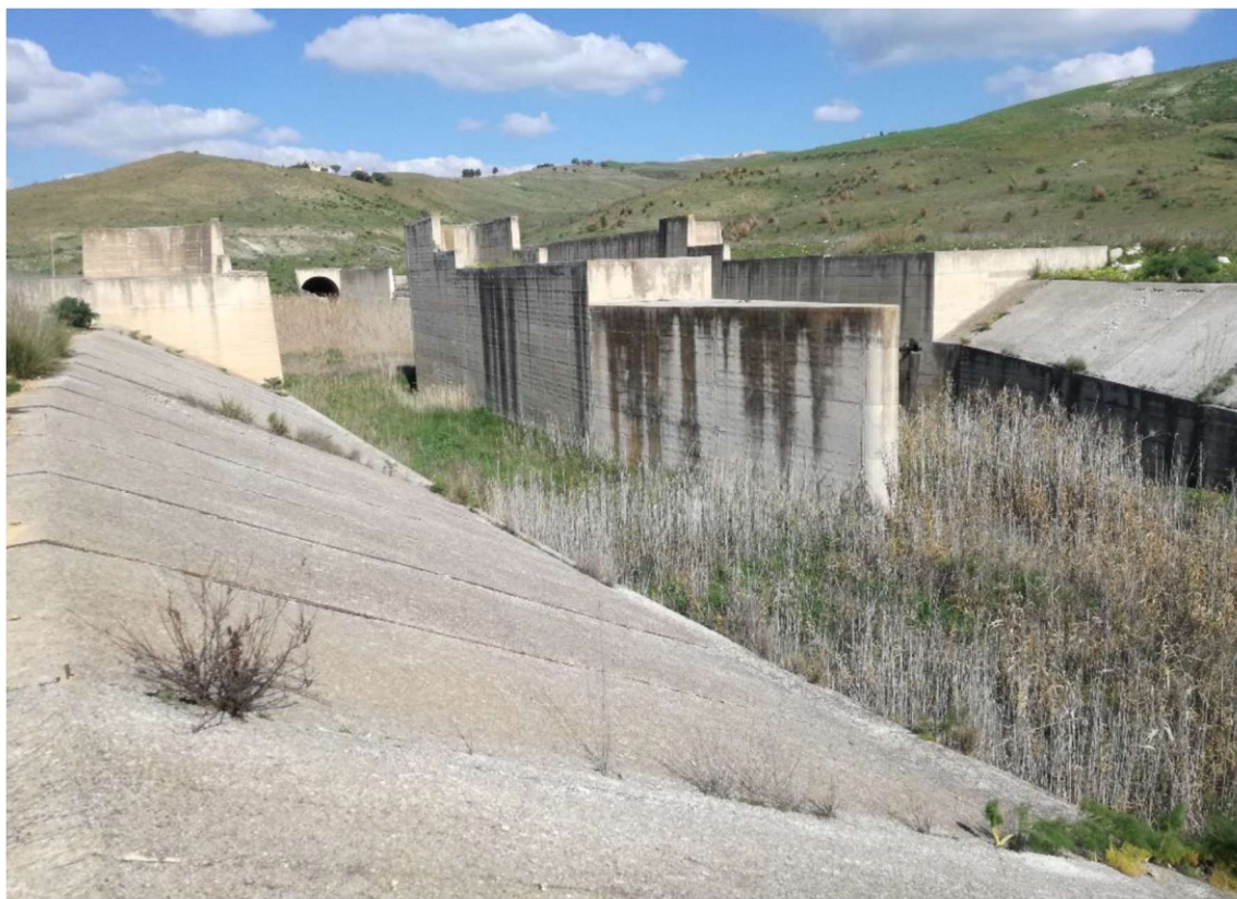
Figura 4.5: Particolare del raccordo tra la vasca il canale di restituzione
