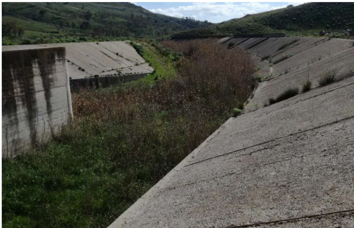
Figura 4.6: Canale di restituzione – Fenomeni di smottamenti di terreno in alveo
