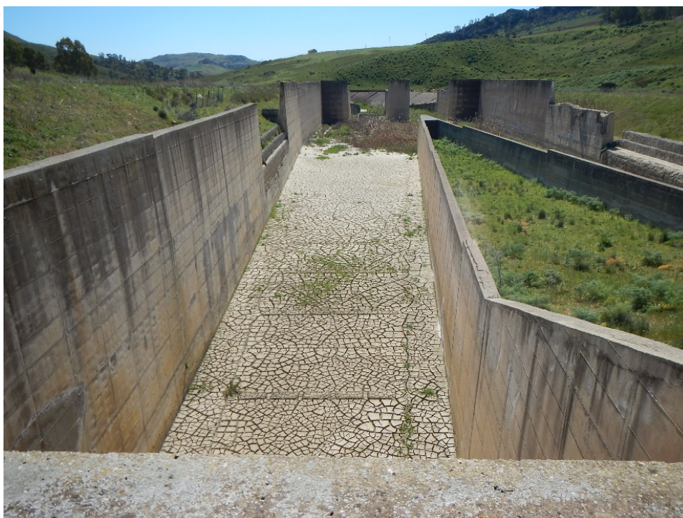
Figura 5.2: Vasca di dissipazione – Sbocco della galleria scarico di superficie sinistro – Porzioni di muro crollate
