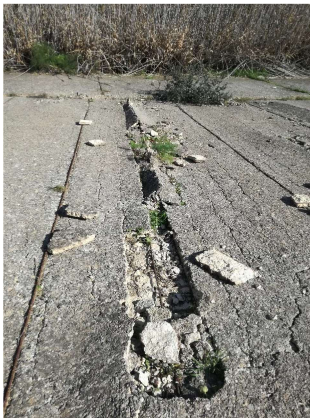
Figura 4.7: Canale di restituzione – Deterioramento calcestruzzo sulle sponde
