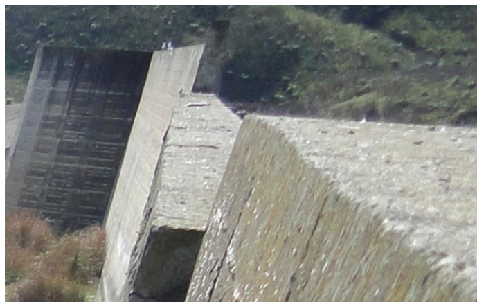
Figura 12.3: Vasca di dissipazione – Iniziale perdita di allineamento tra le elevazioni – Febbraio 2012
