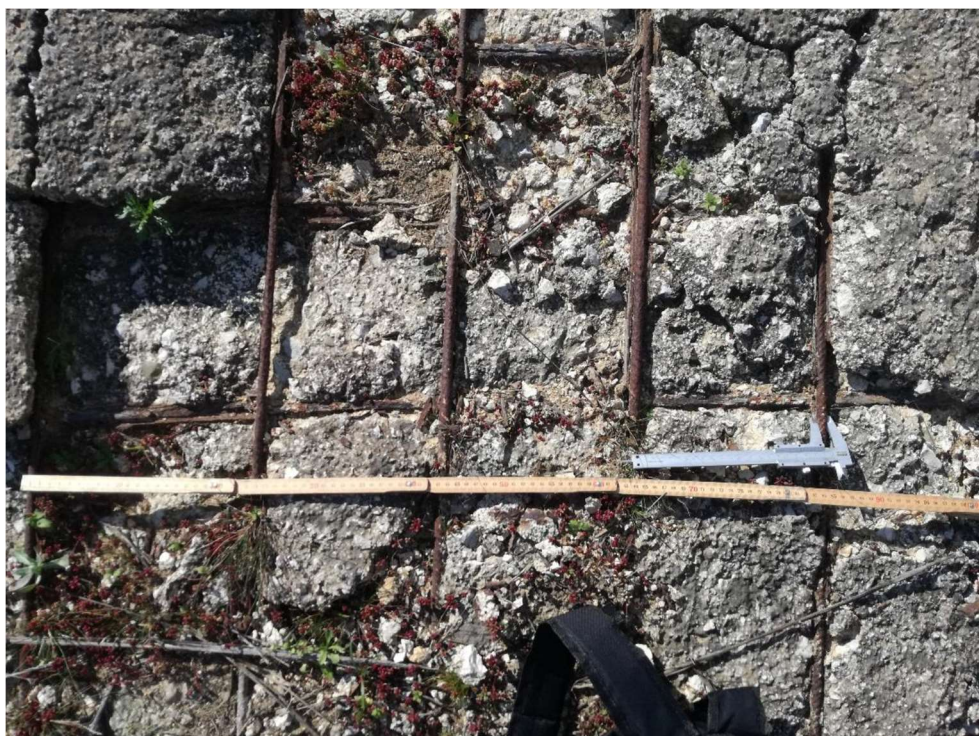
Figura 4.8: Canale di restituzione – Particolare armature ossidate
