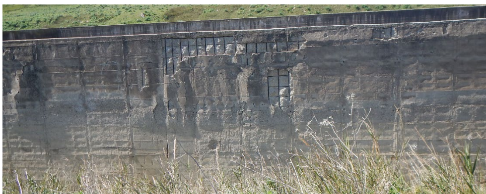
Figura 5.5: Vasca di dissipazione – Degrado del calcestruzzo
