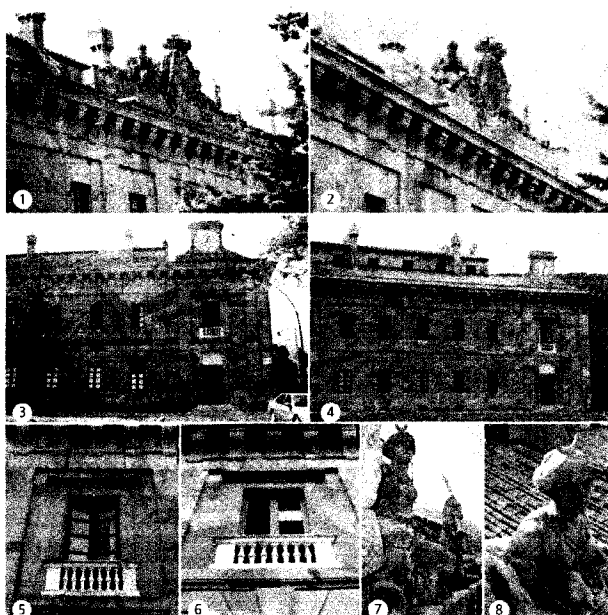
1 Il fregio del prospetto della Real Casina di caccia alla Ficuzza in una immagine del 1997. 2 Lo stesso fregio come si presenta adesso dopo i restauri. 3 Il prospetto principale prima e 4 Dopo i lavori. 5 Il balcone del prospetto principale nel '97 e 6 adesso. 7 La statua che raffigura Diana prima e 8 dopo l'intervento di recupero.
