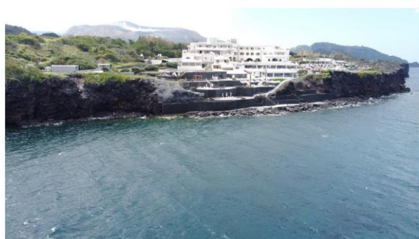
Figura 27 - foto stato di fatto versante di levante
