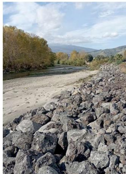
Figura 2 - Stato della difesa in massi esistenti e del greto
