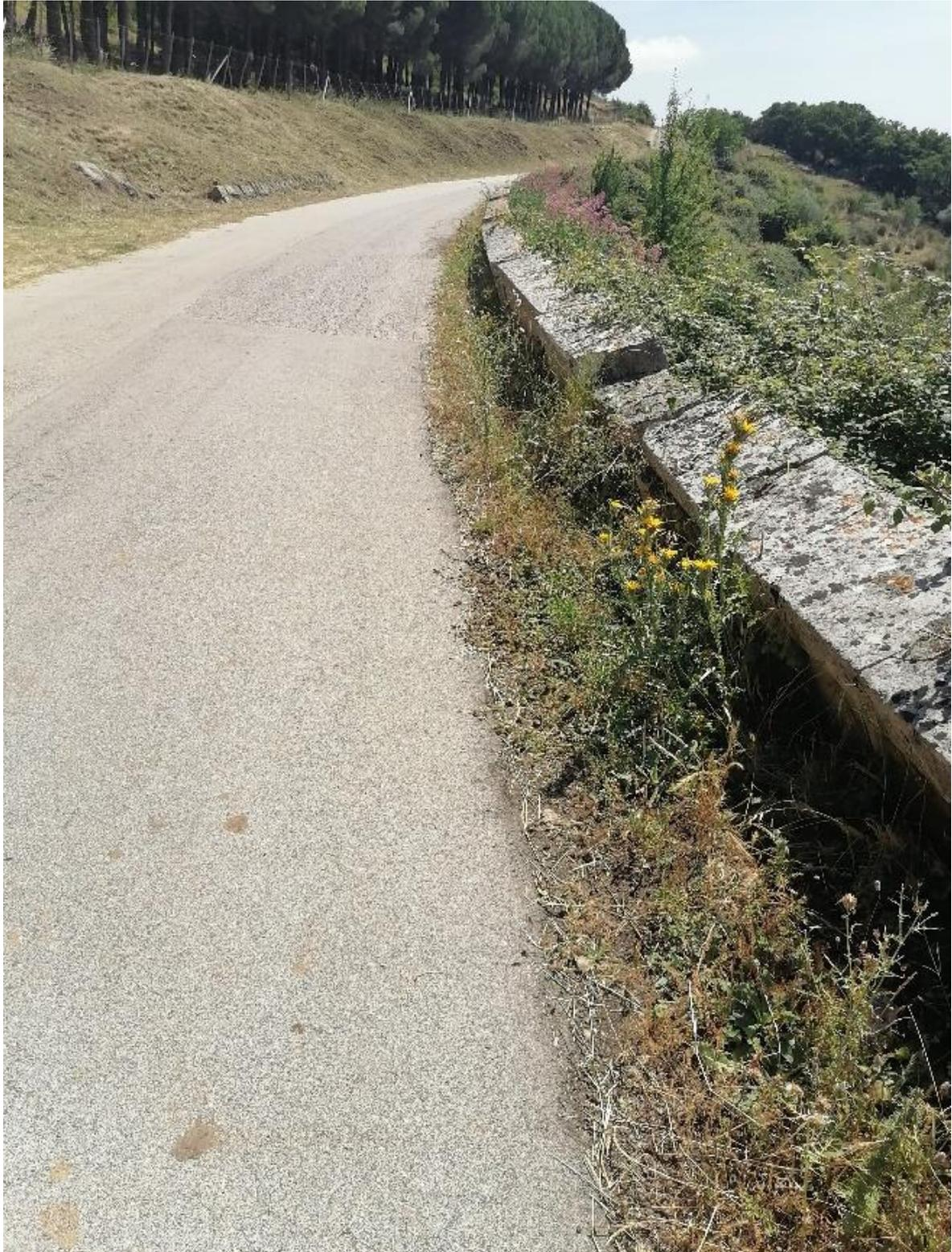
FOTO N. 9 – SP07 VISTA MURO DI CONTENIMENTO SCONNESSO
