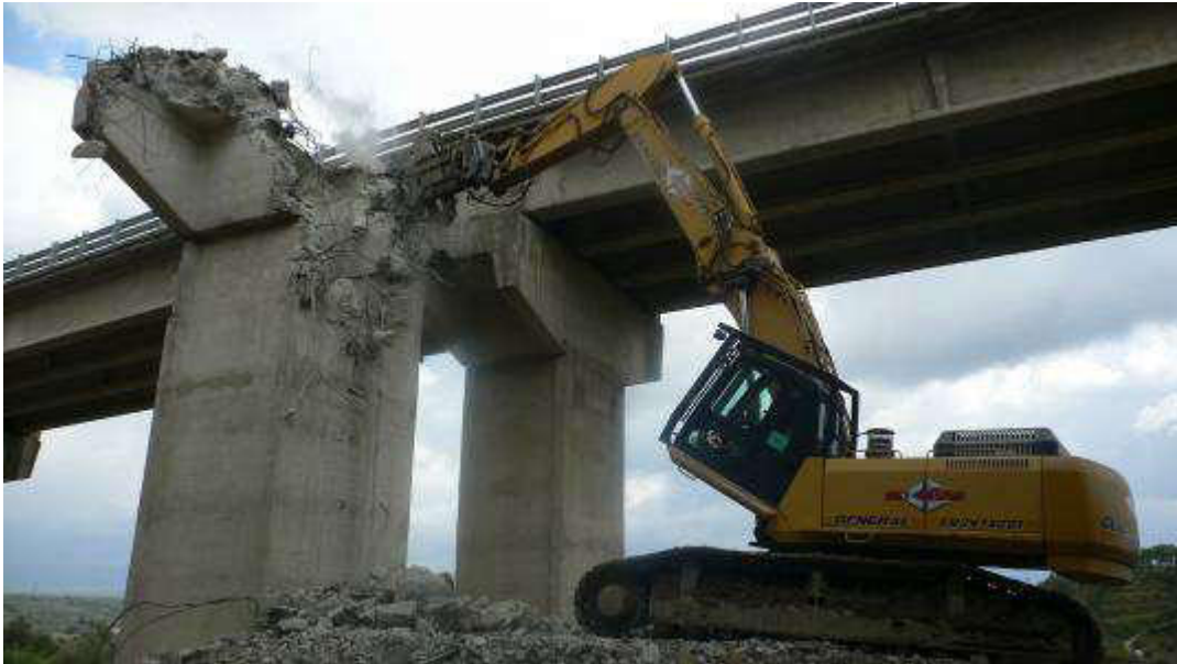
Figura 6: foto esemplificativa demolizione pile con escavatore
