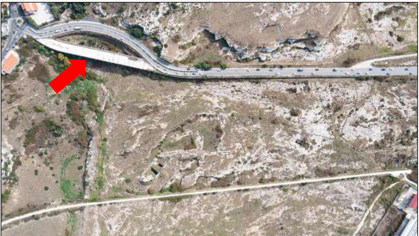
Vista Aerea con indicazione del manufatto oggetto di intervento di demolizione
