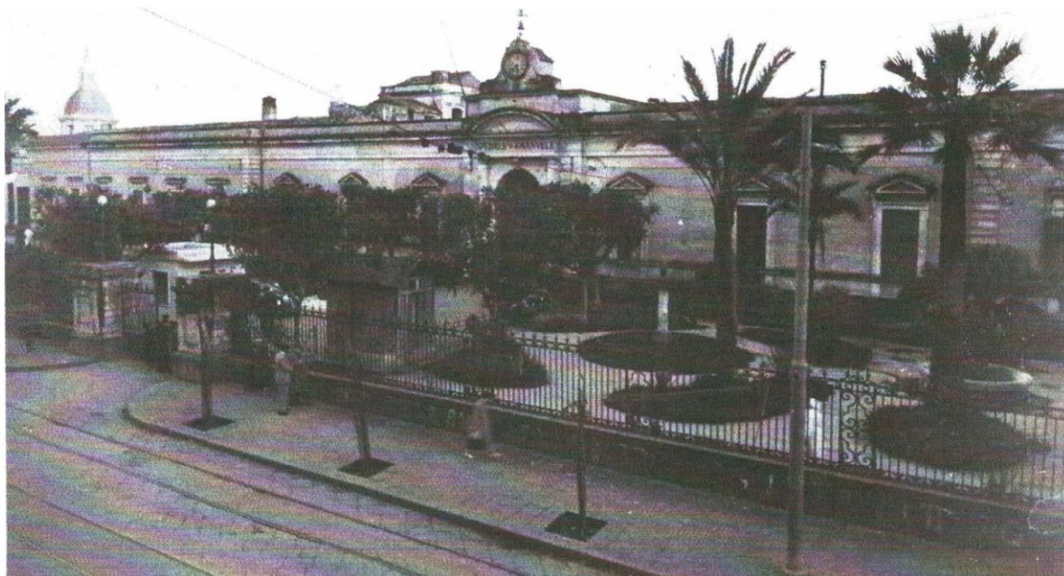
Fig. xx. Foto d'epoca del prospetto Nord su Via Plebiscito del 1950
