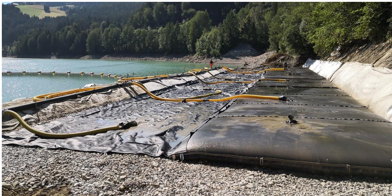
Figura 7-9: geotubi in fase di riempimento
