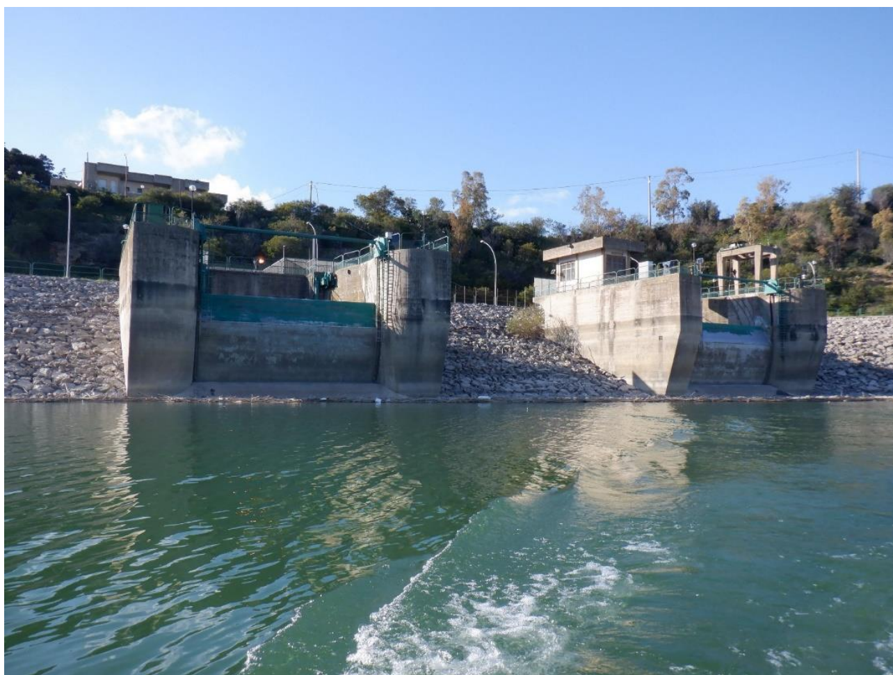
Figura 5-7: scarichi di superficie della diga di Poma
