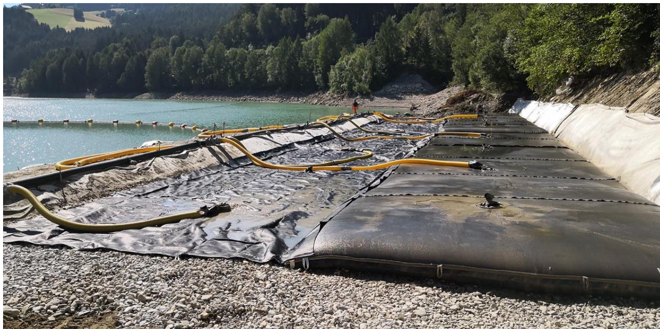
Figura 7-8: geotubi in fase di riempimento
