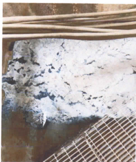
Figura 6. Particolare delle incrostazioni biancastre e concentrazione di H_2S rilevata.
