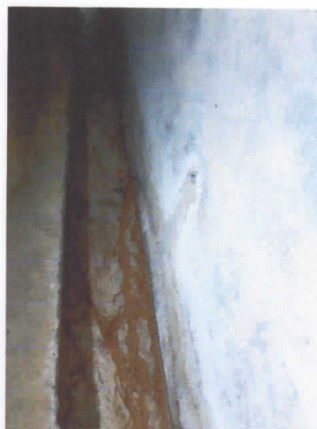
Figura 4. Ingresso cunicolo drenante con presenza di fanghi sedimentati di colore giallo.
