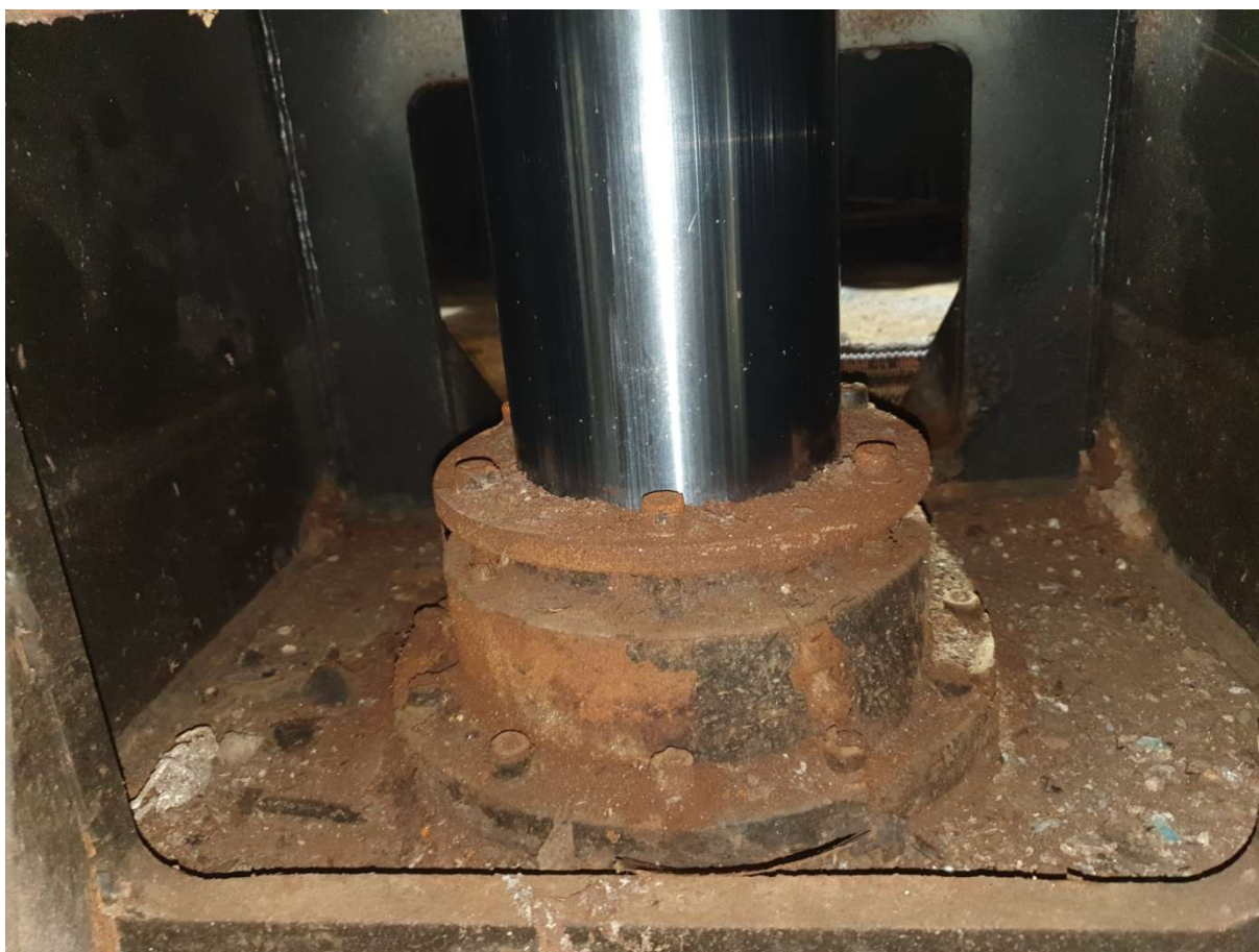
Figura 6 - Tenuta idraulica a baderna della paratoia di valle
