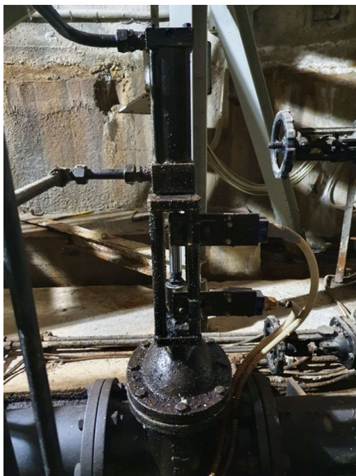
Figura 9 - Valvole con attuazione oleodinamica
