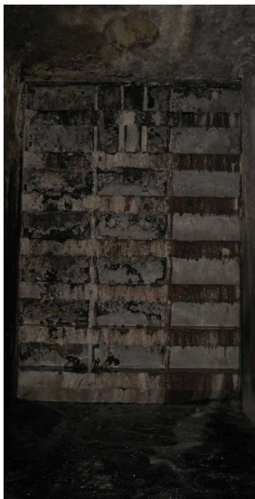
Figura 5 (sinistra) Vista frontale della paratoia di valle. (destra) Dettaglio del dado terminale dello stelo della paratoia
