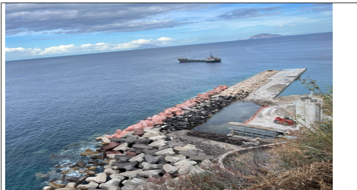
Lavori del porto alla data del 3 ottobre 2022 - Diga foranea
