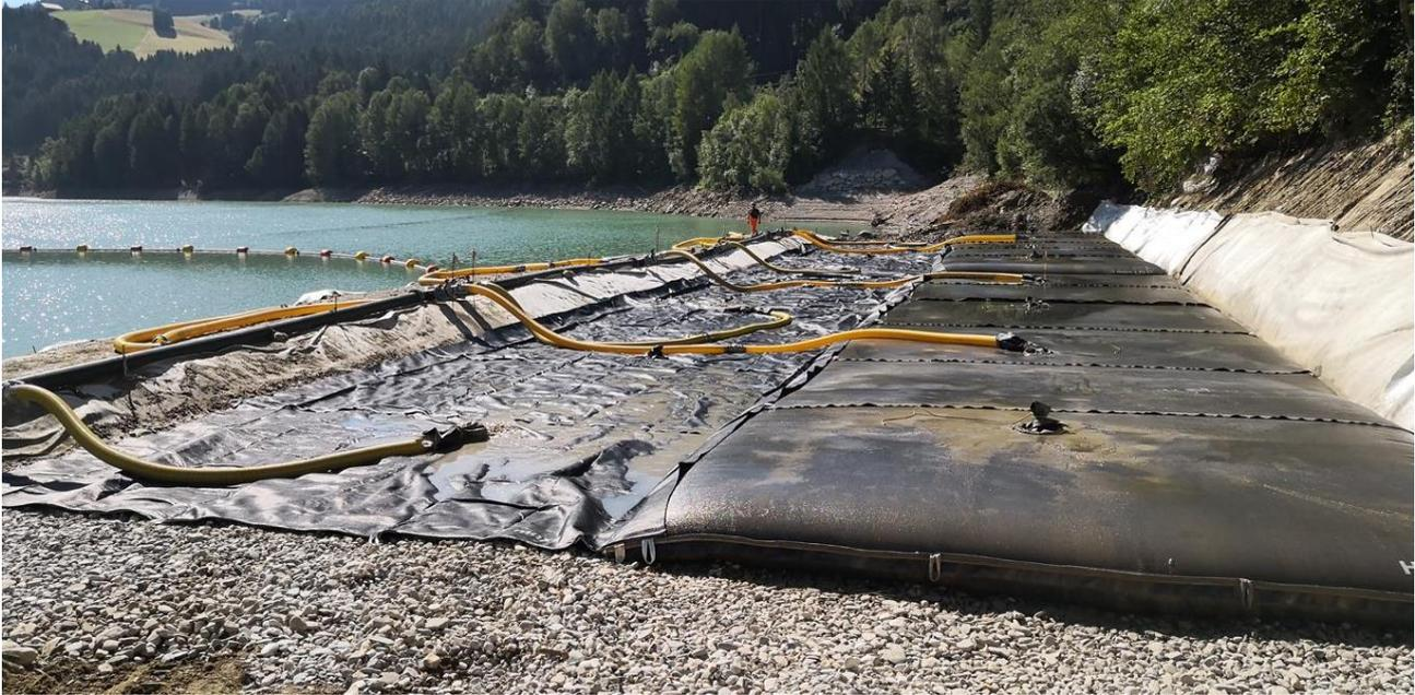
**Figura 7-8: geotubi in fase di riempimento**
