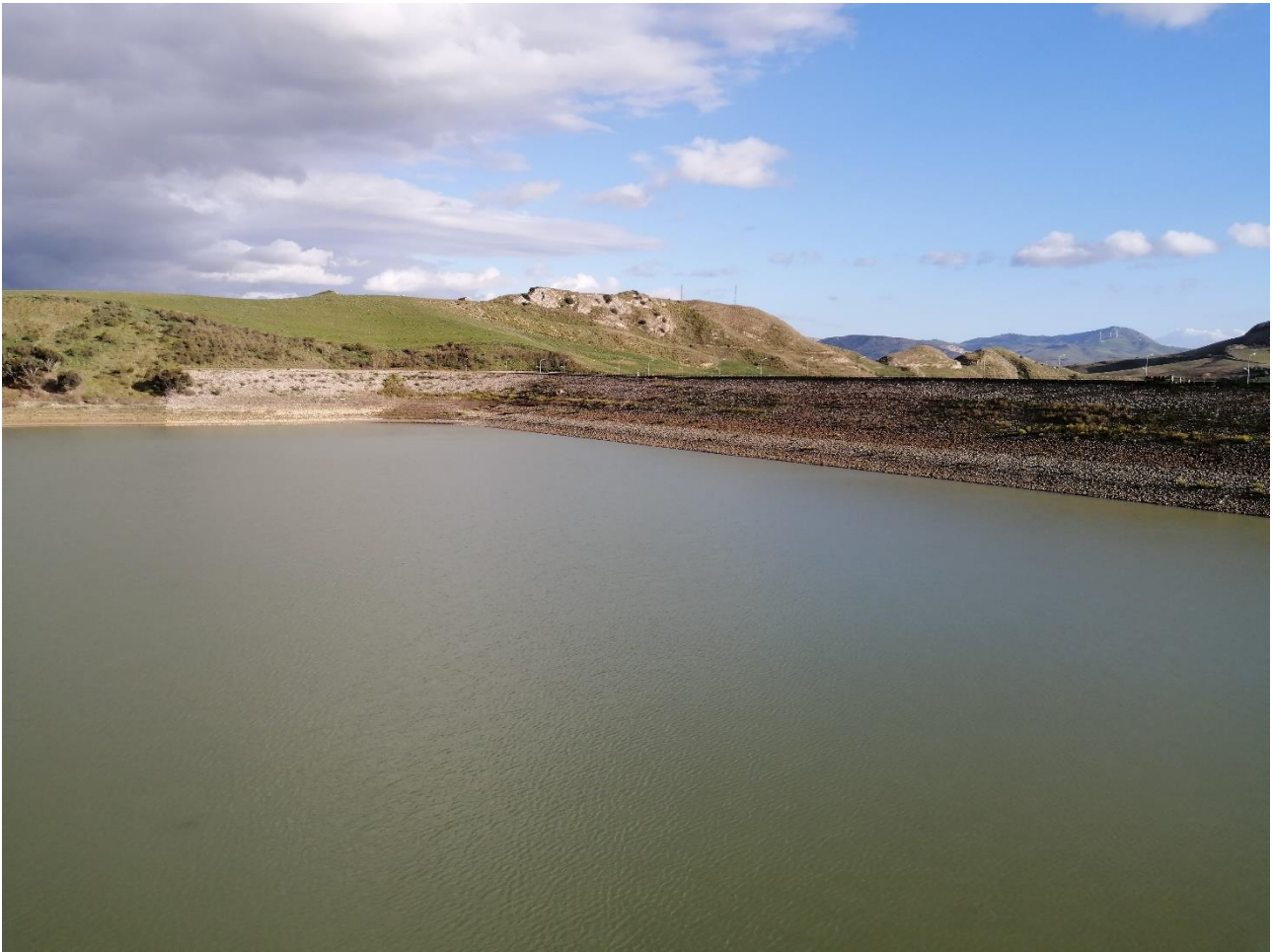
Figura 5-2: diga di Sciaguana
