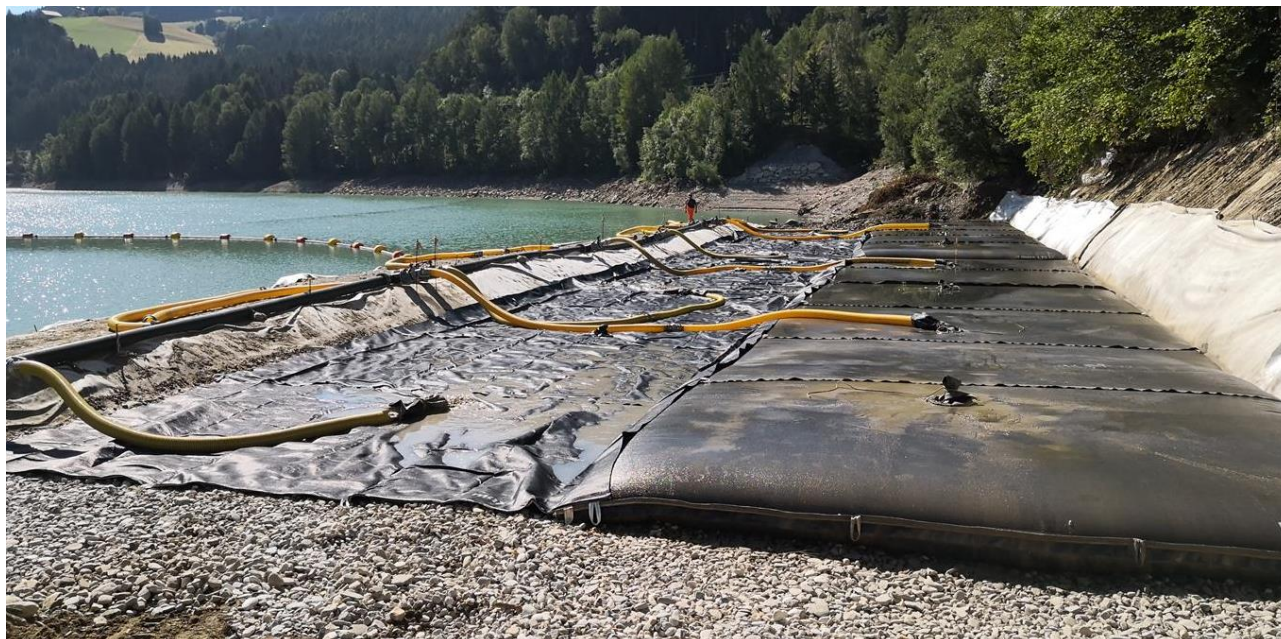
Figura 0-2: geotubi in fase di riempimento
