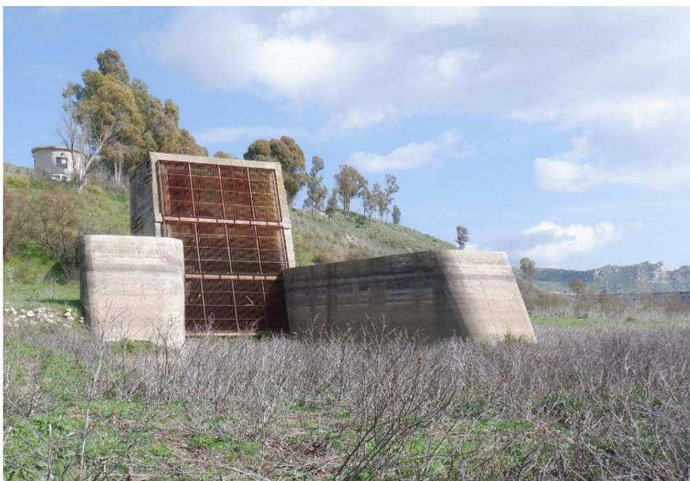
**Figura 4-1: griglie a protezione dell'imbocco dello scarico di fondo e dell'opera di presa della diga di Gibbesi**
