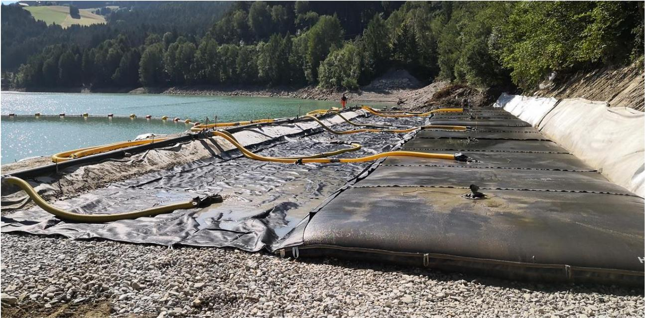
**Figura 7-8: geotubi in fase di riempimento**
