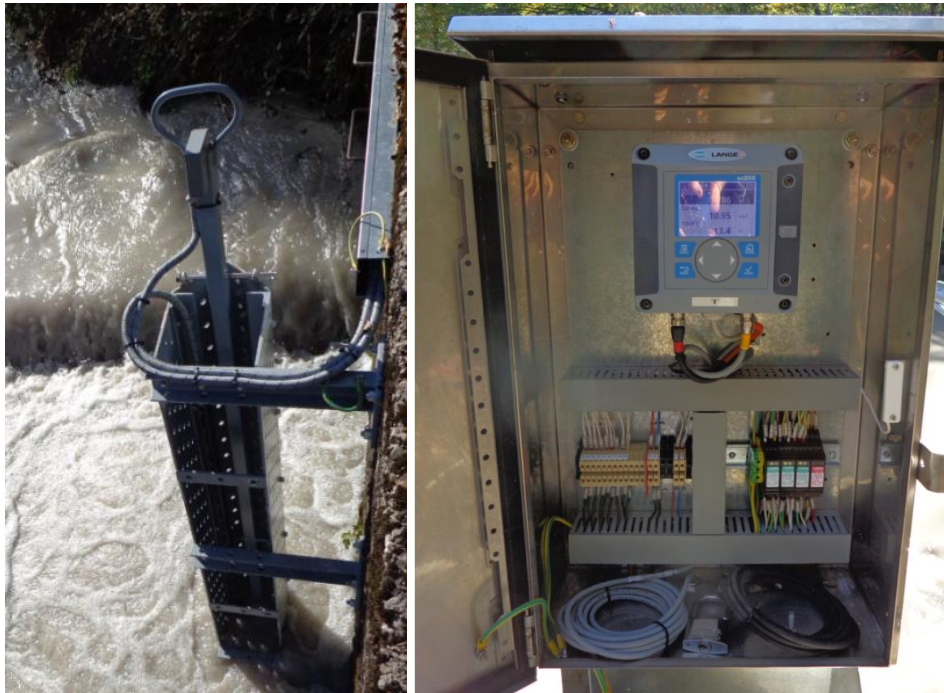
Figura 14-6: esempio di sonda fissa per la misurazione dei solidi sospesi
