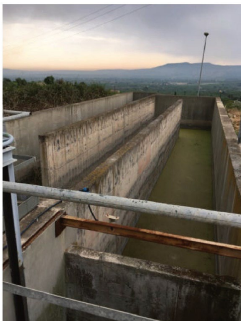
Figura 32 Labirinto di clorazione.
