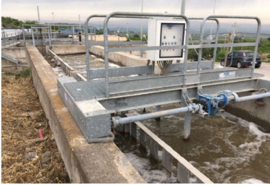
Figura 29 Unità di dissabbiatura-disoleatura.
