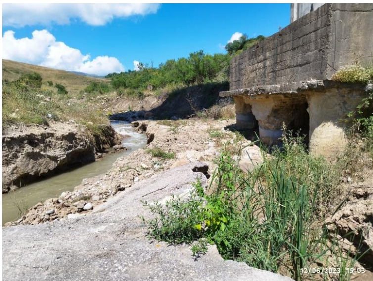
Foto n. 8 (a-b-c) – Tratto fiume fronte pila n.9
