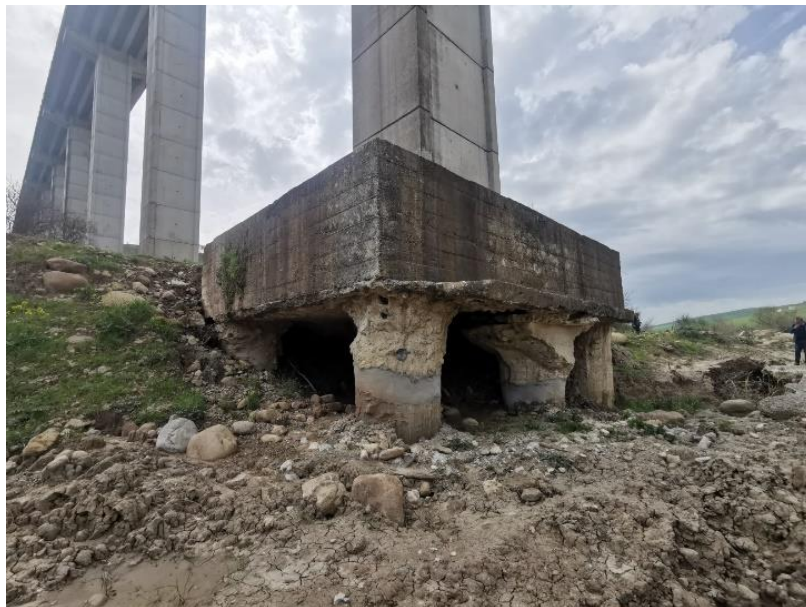
Foto n. 6 (a-b) – Pila n.9
