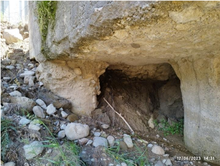
Foto n. 7 (a-b-c-d) – Testa dei pali di fondazione
