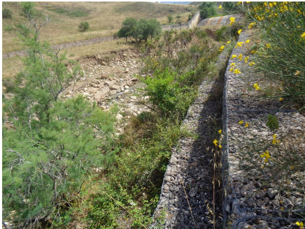
Foto n. 10 – gabbionate lungo gli argini, a monte del viadotto e in prossimità della soglia
