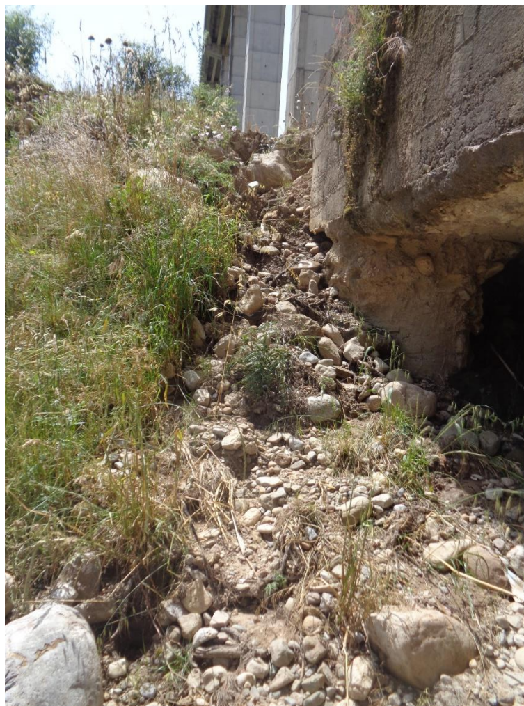
Foto n. 9 – particolare del recapito del V.ne Nero adiacente, sul lato monte, alla pila n. 9
