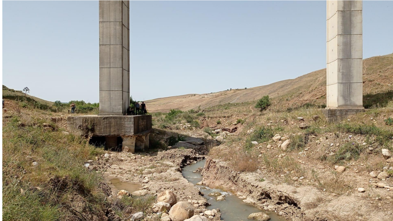
Foto n. 2 – vista con pila n. 9 in sinistra idraulica
