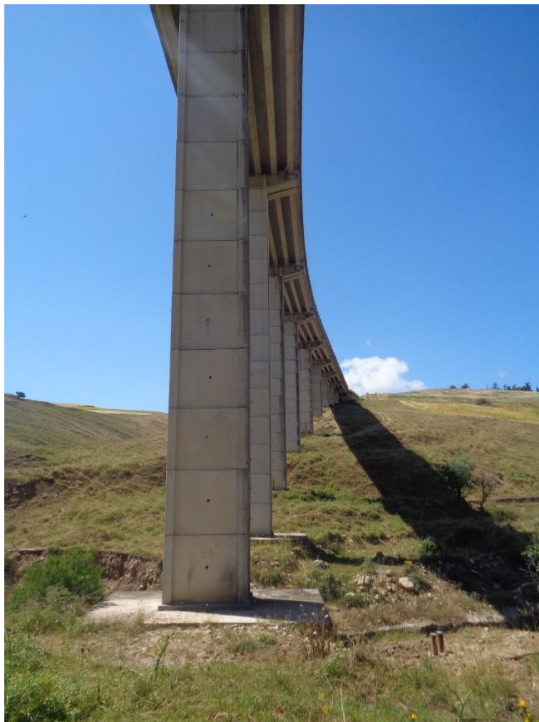
Foto n. 3 – pila n. 9 (in primo piano) vista da monte
