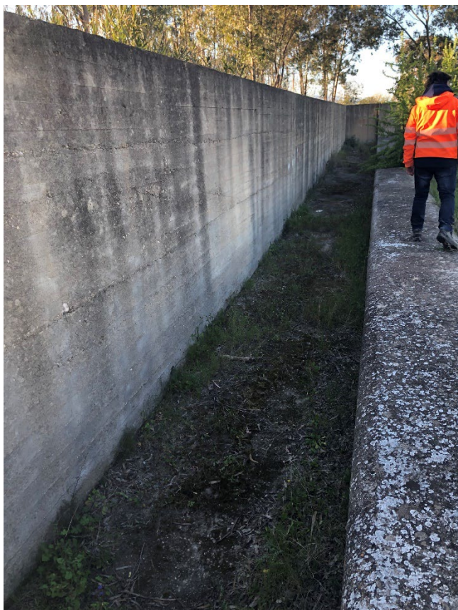
FIGURA 4-5 SCARICO DI SUPERFICIE. A SINISTRA STRAMAZZO, A DESTRA GALLERIA (FOTO DEL 12/02/2019).
