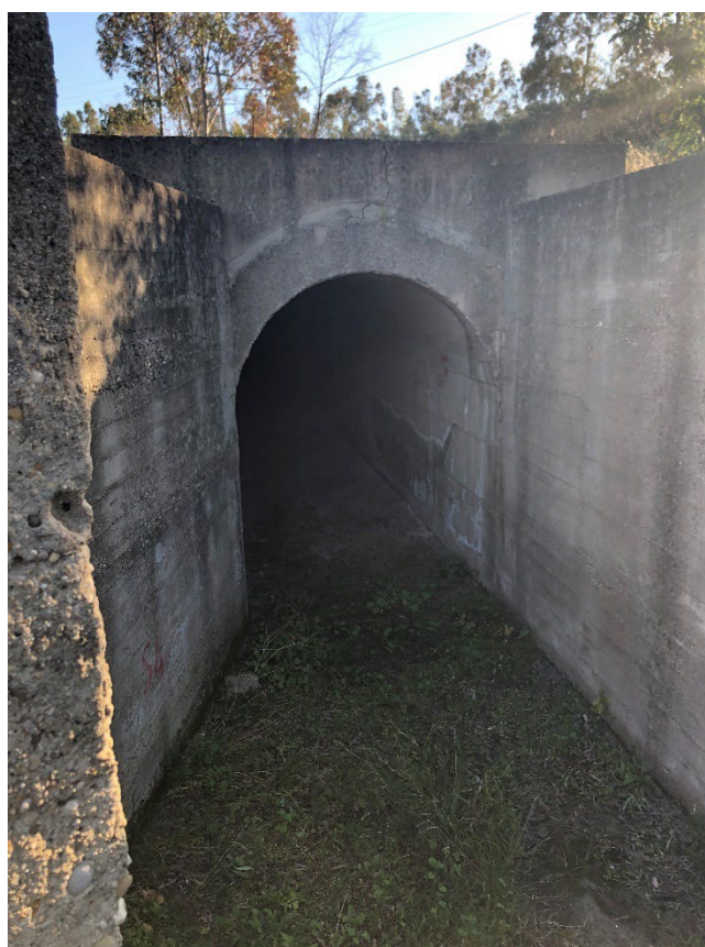
FIGURA 4-5 SCARICO DI SUPERFICIE. A SINISTRA STRAMAZZO, A DESTRA GALLERIA (FOTO DEL 12/02/2019).
