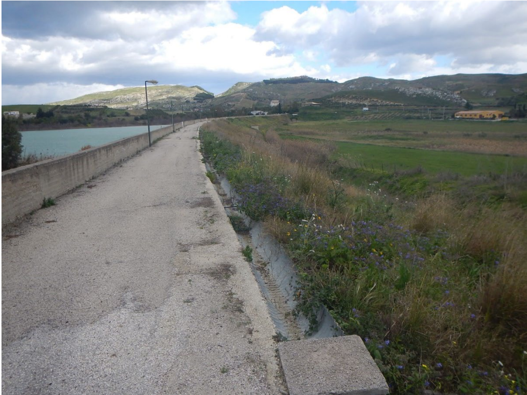
FIGURA 4-4 INVASO, CORONAMENTO E PARAMENTO DI VALLE (FOTO DEL 12/02/2019).
