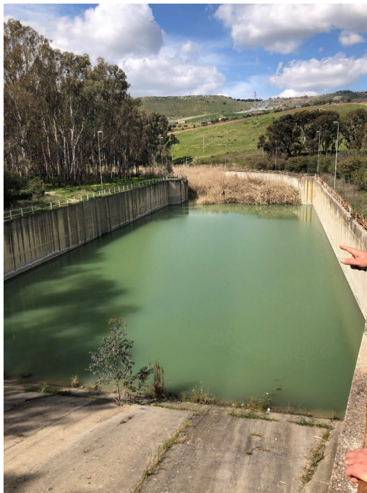
FIGURA 4-5 – VASCA DI SMORZAMENTO DELLO SCARICO DI SUPERFICIE
