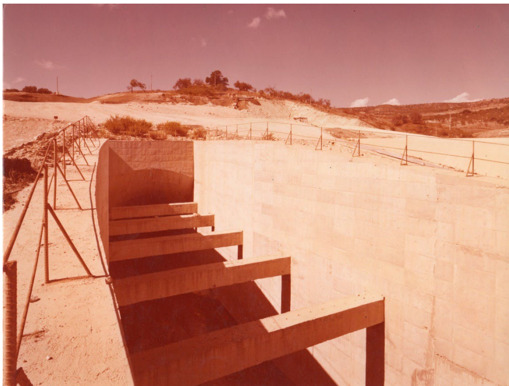
FIGURA 5-4 – FOTO SCATTATE DURANTE LA REALIZZAZIONE DELL'INVASO, CON OPERA DELLO SCARICO DI FONDO COMPLETATA
