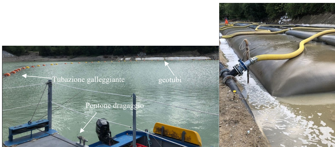
FIGURA 5-2 – SINISTRA: SISTEMA DI DRAGAGGIO IDRAULICO CON TUBAZIONE GALLEGGIANTE DI REFLUIRIMENTO CON POSA DIRETTA IN GEOTUBI. DESTRA: SISTEMA IN LINEA DI MISCELAZIONE FLOCCULANTE E RIEMPIMENTO IN SERIE DEI GEOTUBI
