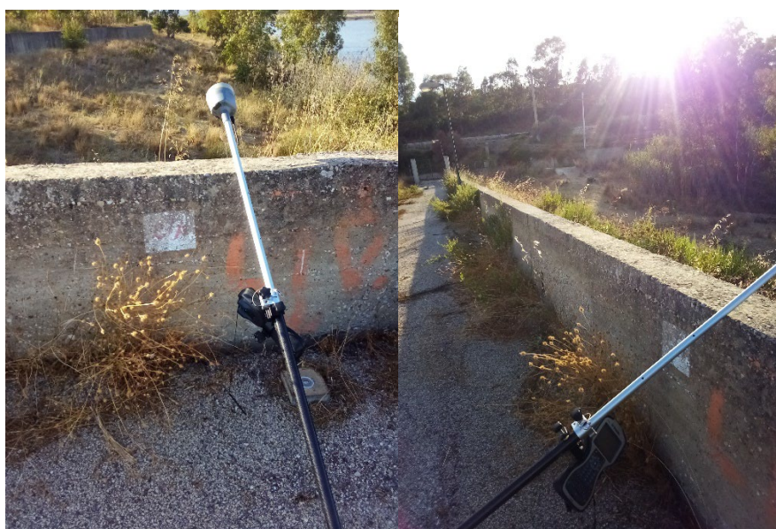
Figura 1 – Fasi di verifica dei cs lungo il coronamento della diga.
