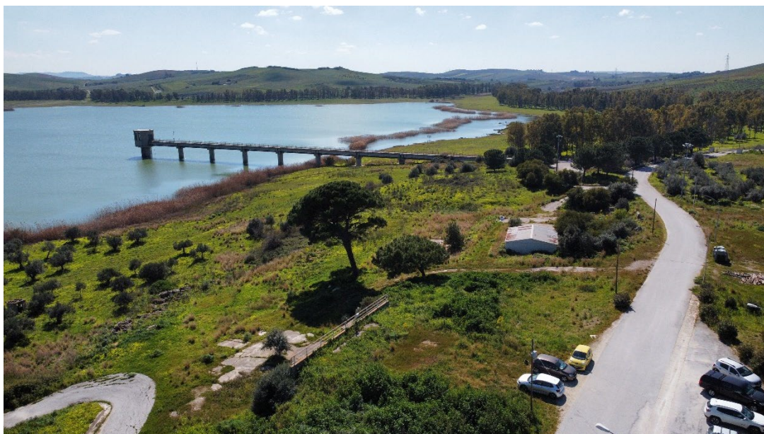
FIGURA 4-8 – PRESA IRRIGUA IN SINISTRA INVASO E STRADA DI ACCESSO ALLA CASA DI GUARDIA.
