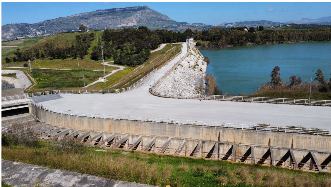
FIGURA 4-5 – CORPO DIGA E SCARICO DI SUPERFICIE. VISTA VERSO VALLE (CON VASCA DI DISSIPAZIONE) ED IN ASSE ALLA DIGA (FOTO DI MARZO 2022).
