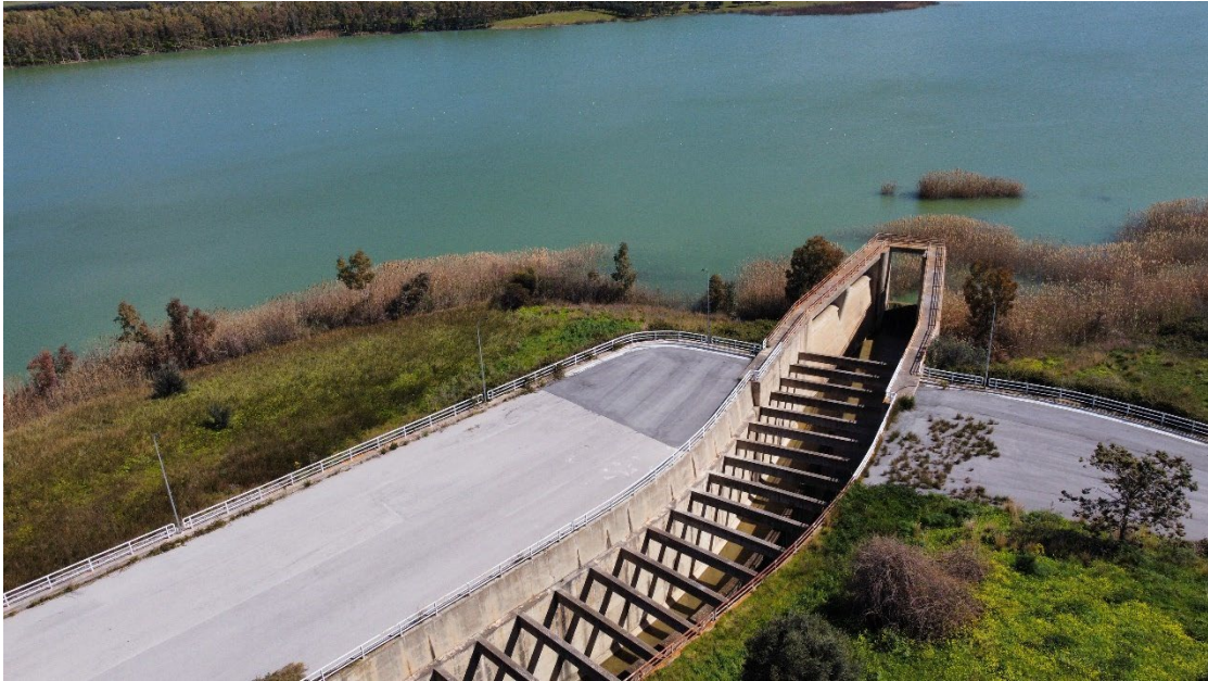
FIGURA 4-6 –SCARICO DI SUPERFICIE. VISTA VERSO INVASO (FOTO DI MARZO 2022).
