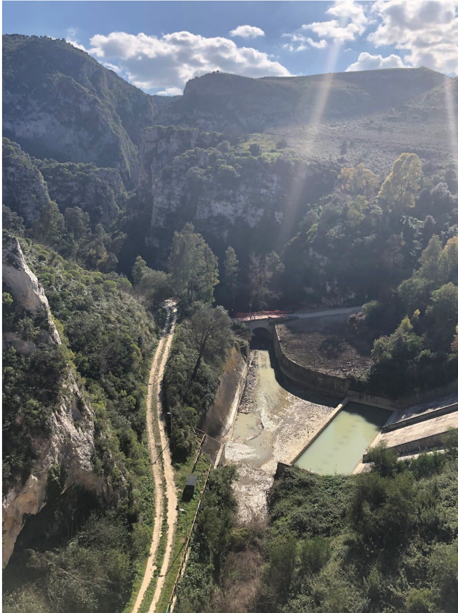
FIGURA 4-2 – GOLA IMMEDIATAMENTE A VALLE DELL'INVASO. VISIBILE LA VASCA DI DISSIPAZIONE ED ATTRAVERSAMENTO DEL CARBOJ.
