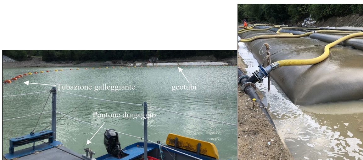
FIGURA 5-2 – SINISTRA: SISTEMA DI DRAGAGGIO IDRAULICO CON TUBAZIONE GALLEGGIANTE DI REFLUITAMENTO CON POSA DIRETTA IN GEOTUBI. DESTRA: SISTEMA IN LINEA DI MISCELAZIONE FLOCCULANTE E RIEMPIMENTO IN SERIE DEI GEOTUBI
