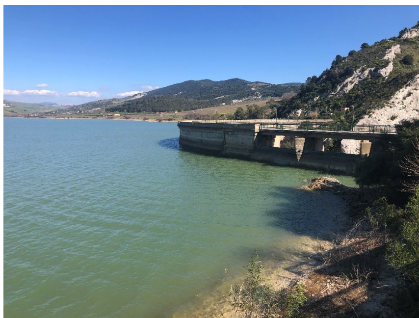
FIGURA 4-8 – DIGA AD ARCO LATO INVASO, CORONAMENTO E SCARICO DI SUPERFICIE
