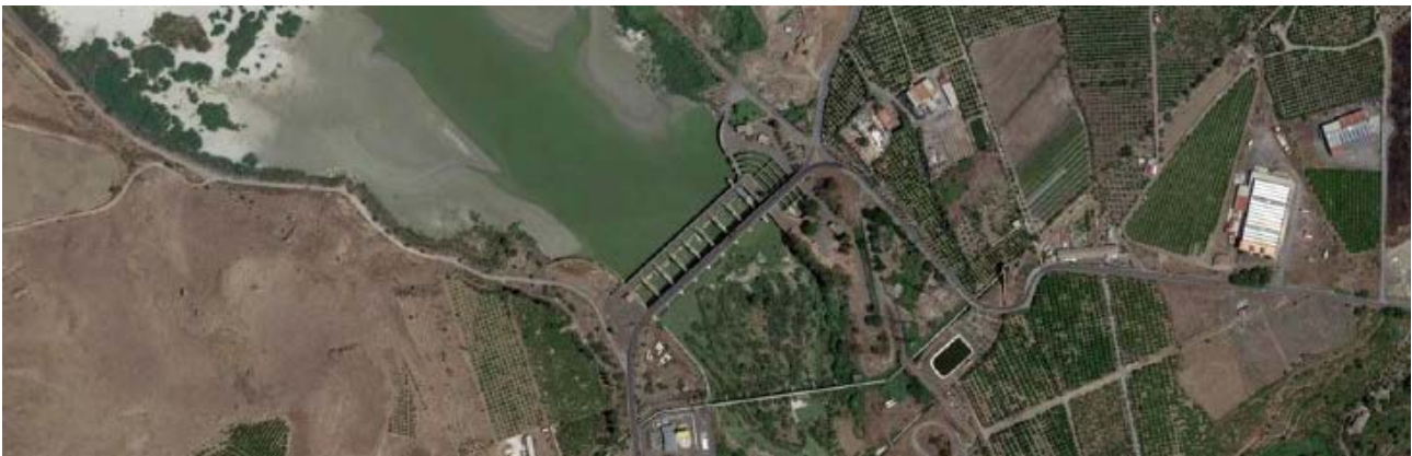
Figura 3-1: immagine satellitare della traversa fluviale di Ponte Barca
