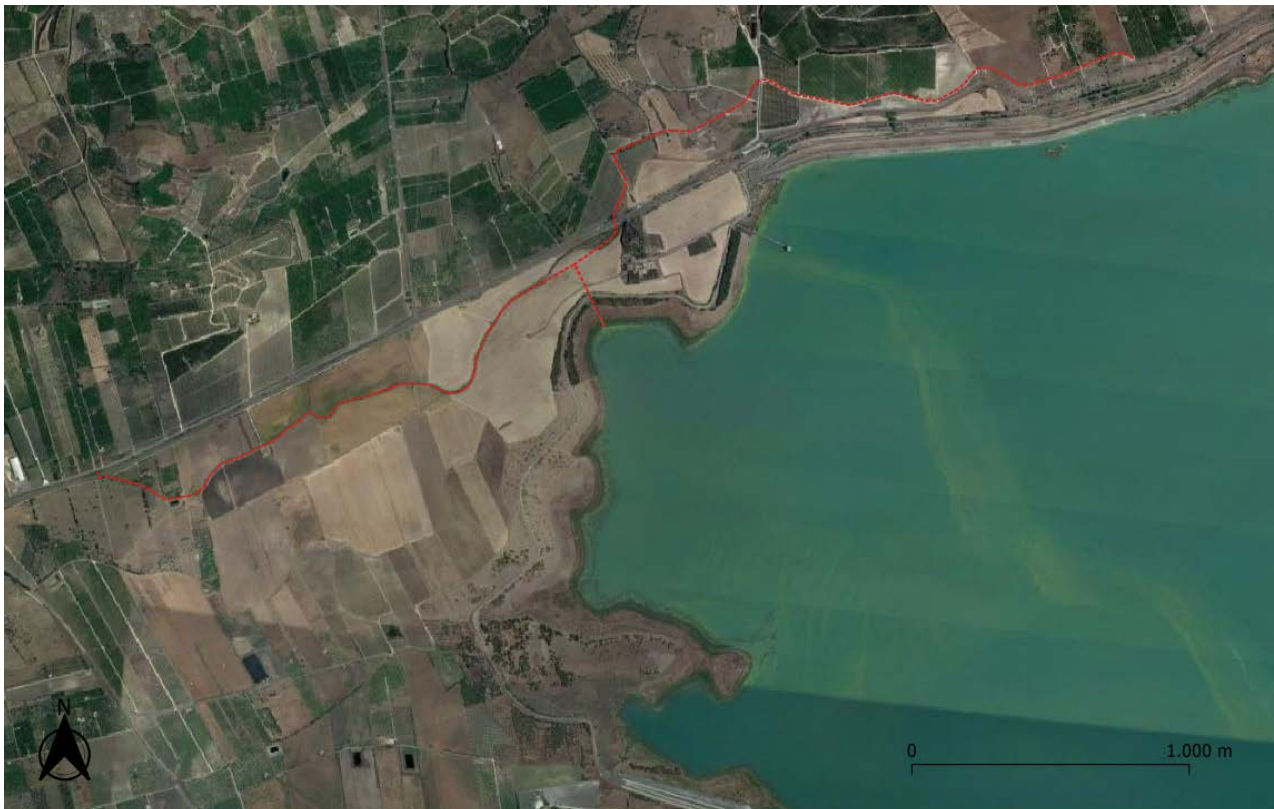
Figura 3-7: canale di gronda nel settore nord-occidentale dell'invaso
