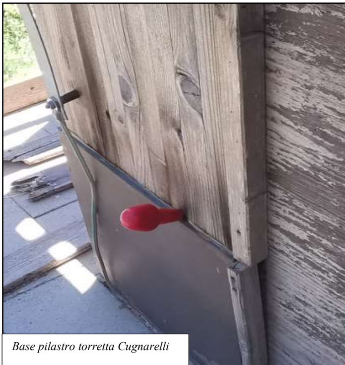
Base pilastro torretta Cugnarelli – particolare marciume interno e attacco insetti xilofagi
