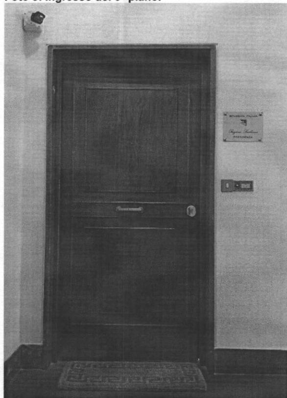
Foto 3: ingresso del 6° piano.
