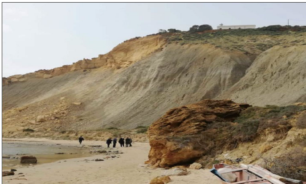
Panoramica dei dissesti 066-1RL-015 e 066-1RL-009 di Capo Rossello. Si distinguono sia la nicchia di distacco sia la zona di accumulo delle calcareniti franate dal dissesto 066-1RL-015
