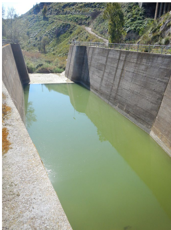
FIGURA 4-7 – VASCA DI DISSIPAZIONE (FOTO DI MARZO 2019)
