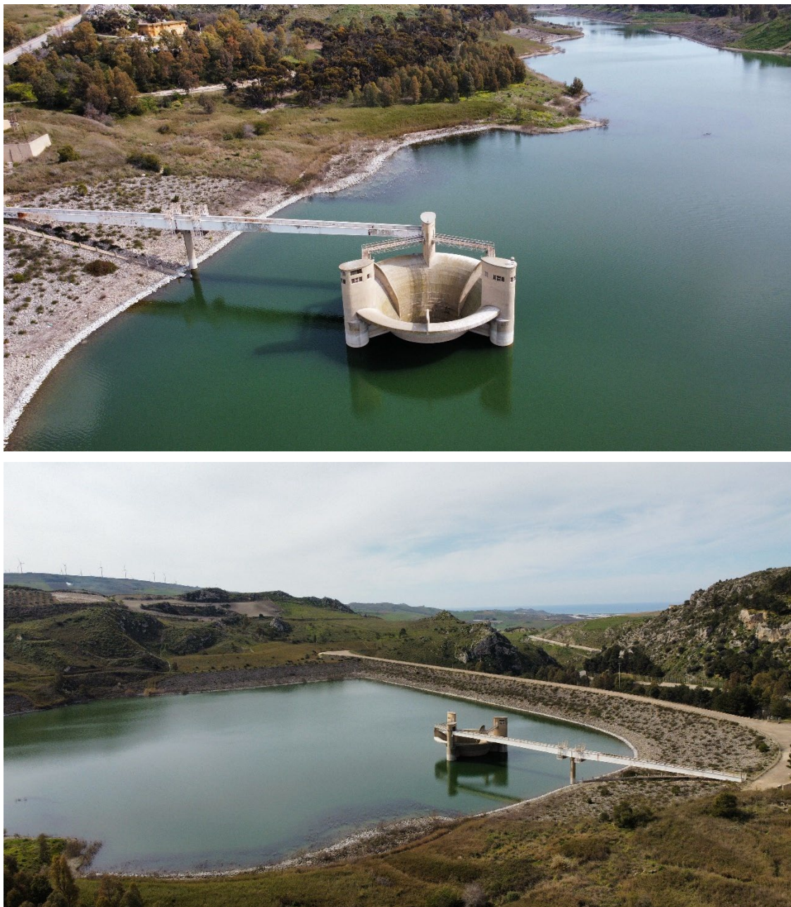
FIGURA 4-6 – SCARICO DI SUPERFICIE E CORPO DIGA
