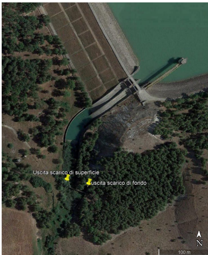
FIGURA 3-6 UBICAZIONE DEGLI SCARICHI DI SUPERFICIE E DELLO SCARICO DI FONDO, CHE CONVERGONO A VALLE DELLA DIGA (FOTO GOOGLE EARTH, 2019)
