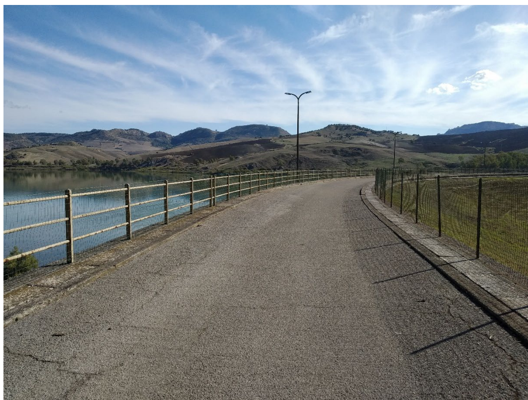
FIGURA 4-1 FOTO DEL CORONAMENTO DELLA DIGA.
