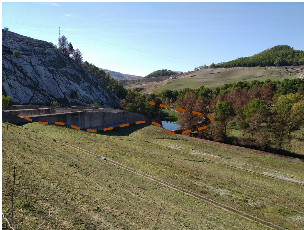
FIGURA 4-2 FOTO DELLO SCARICO DI SUPERFICIE, PARAMENTO DI VALLE. CON TRATTEGGIO È INDICATA LA POSSIBILE UBICAZIONE DELLA TUBAZIONE DI REFLUIMENTO.
