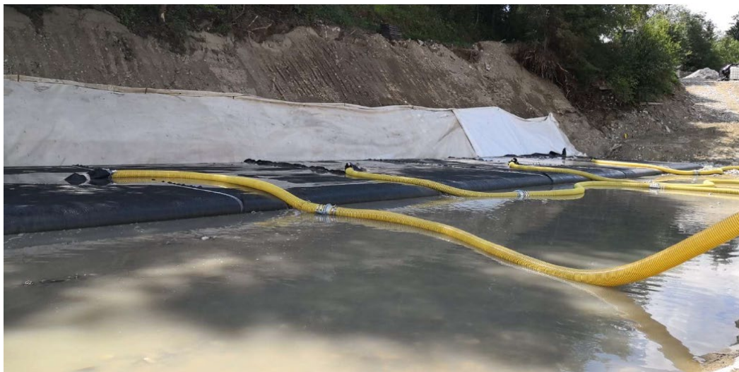
FIGURA 4-5 GEOTUBI CON BOCCHETTE PER IL REFLUIMENTO
