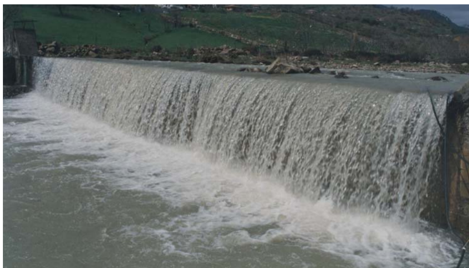
Fiume Martello - Foto Collezione Osservatorio delle Acque
