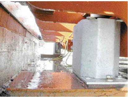
Spazio esistente fra le celle di carico e il muro di testata
