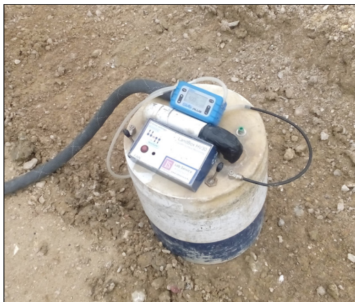
Particolare della cappa sul corpo rifiuti
