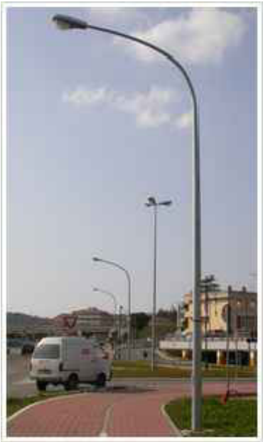
RETE ILLUMINAZIONE PUBBLICA Tipologia esemplificativa di Palo tronco conico a stelo curvato
