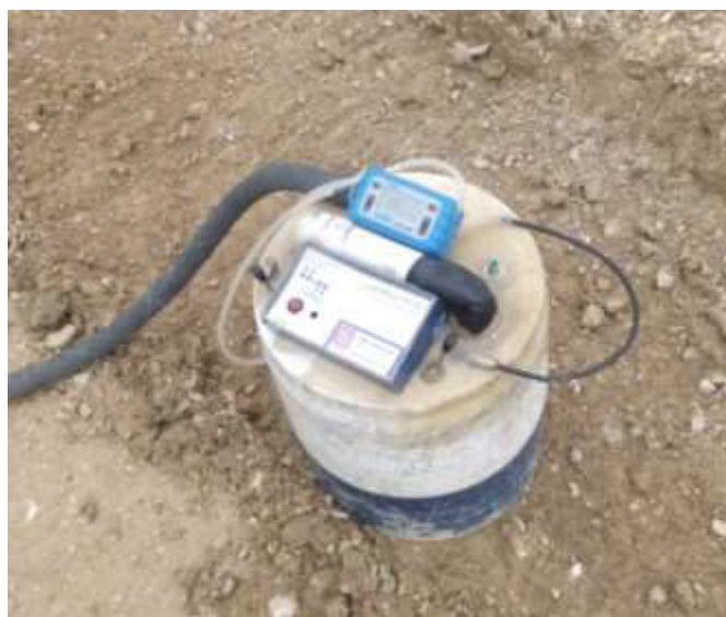
Particolare della cappa sul corpo rifiuti
