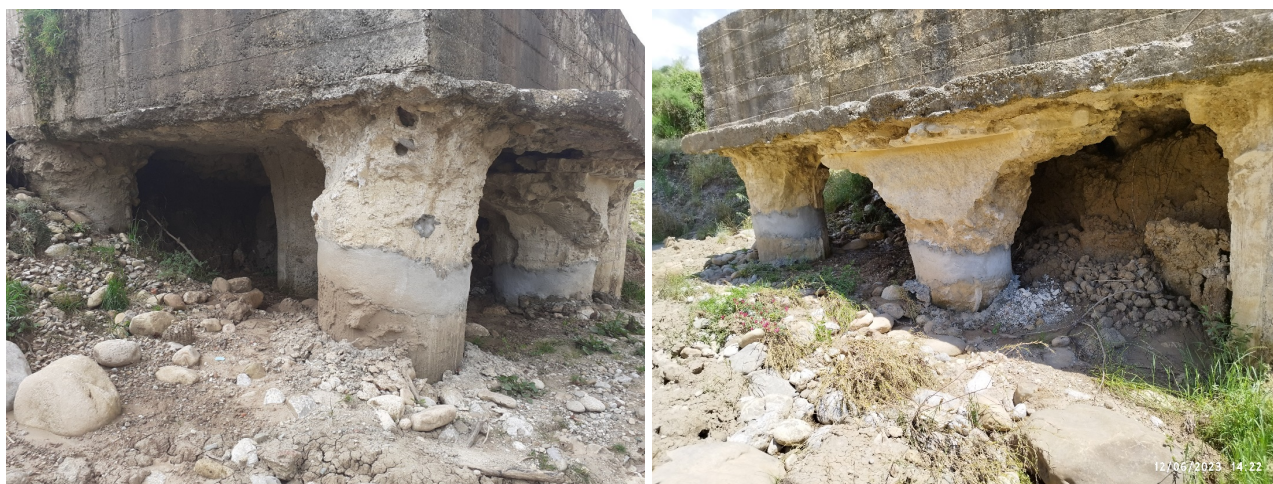
Foto n. 5 (a-b) – Testa dei pali di fondazione
