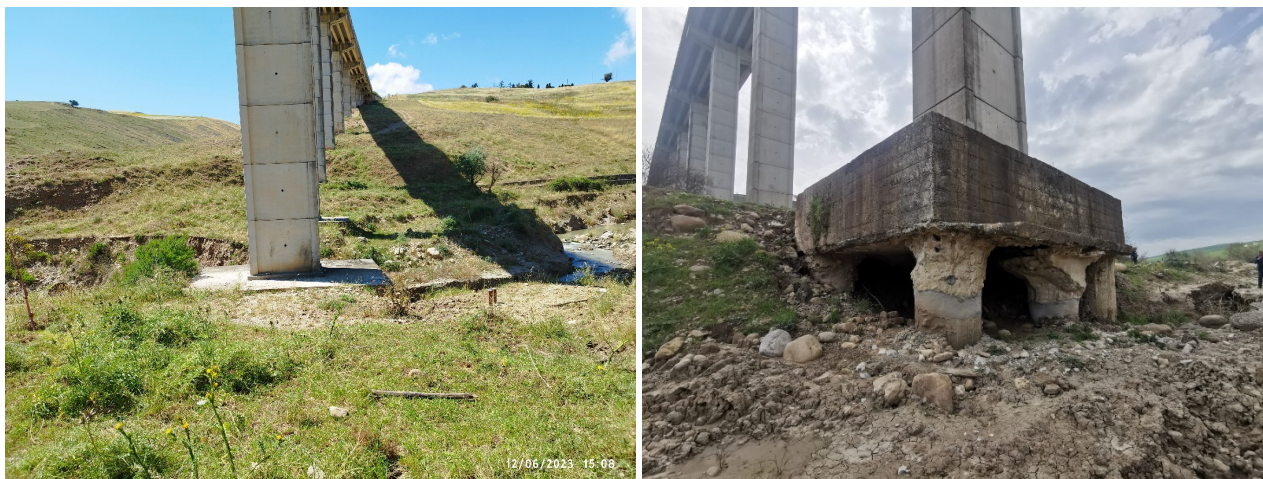
Foto n. 4 (a-b) – Pila n.9
