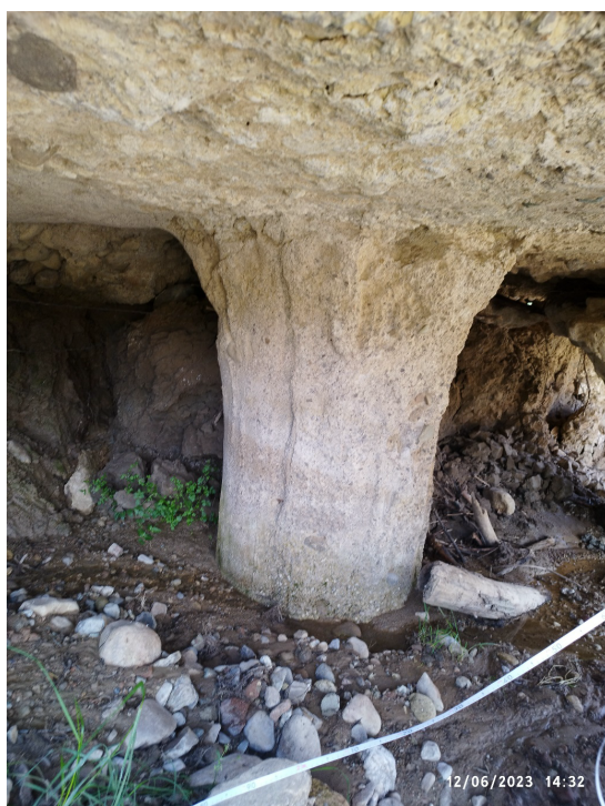
Foto n. 5 (a-b-c-d) – Testa dei pali di fondazione
