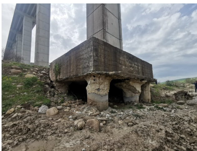
Foto n. 4 (a-b) – Pila n.9
