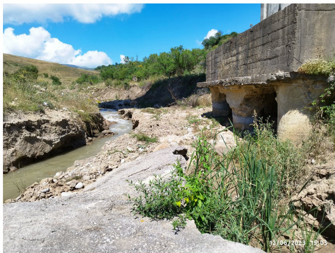
Foto n. 6 (a-b-c) – Tratto fiume fronte pila n.9
